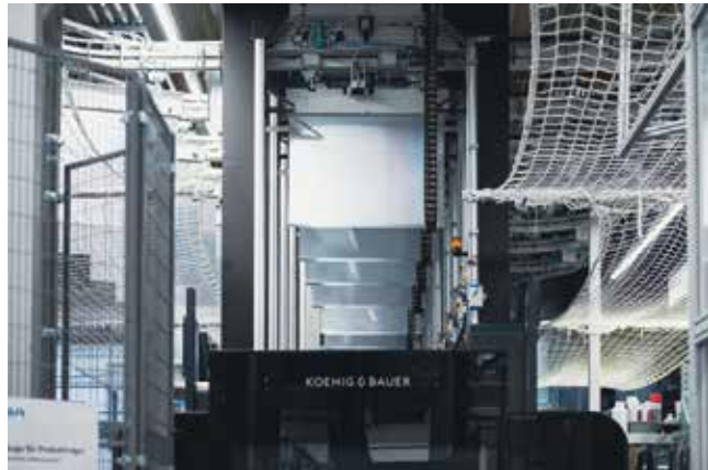
Kalıpların doğrudan ayrı bir baskı ünitesi üzerindeki kalıp değiştiricinin montaj kanalına indirilmesi
